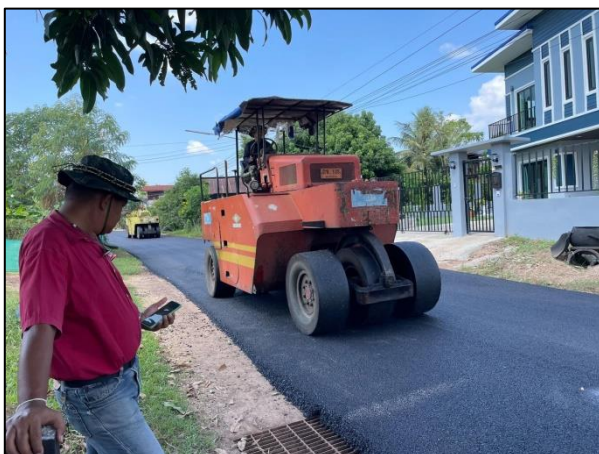
โครงการปรับปรุงผิวจราจรแบบแอสฟัลต์ติกคอนกรีต ถนนสุขาภิบาล บ้านทุ่งฝน หมู่ที่ ๘,๑๑ ตำบลทุ่งฝน อำเภอทุ่งฝน จังหวัดอุดรธานี
